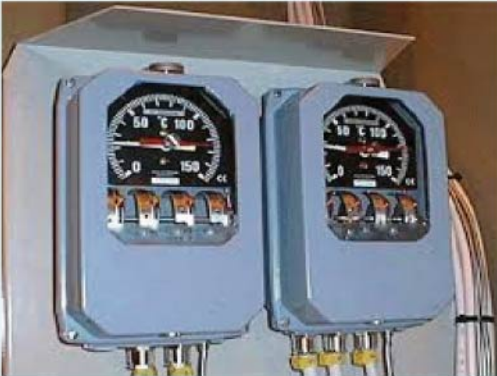
চিত্রঃ অয়েল ও উইভিং টেম্পারেচার ইন্ডিকেটর
